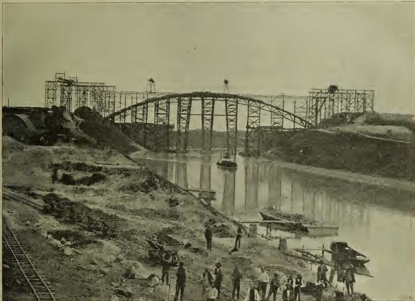
Abbildg. 1. Vom Bau des Nord-Ostsee-Kanals. Bau der Brücke bei Levensau.
